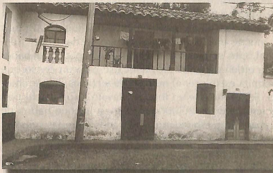
Casa viviente, resago del terremoto (calle Domingo Albuja)
