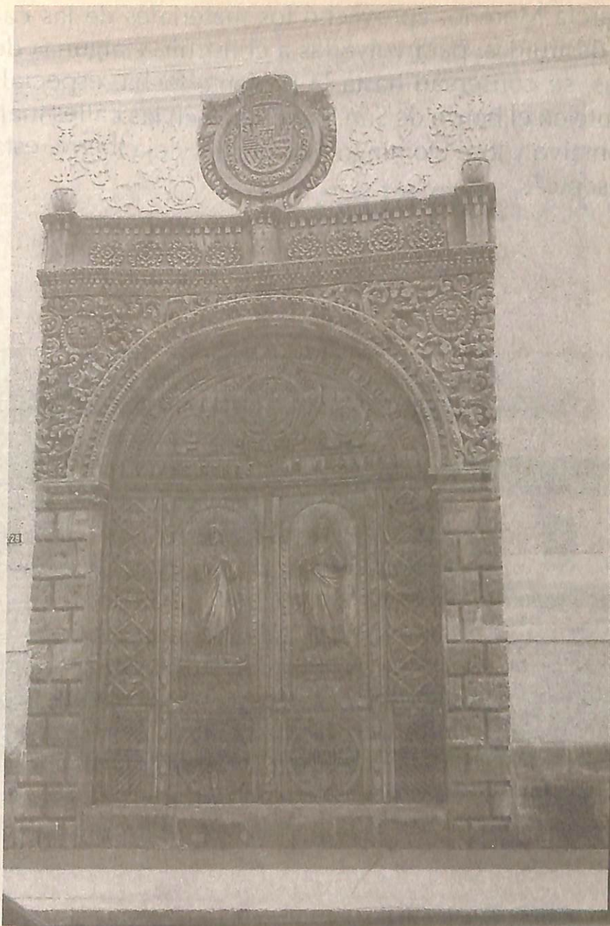
Puerta del Colegio Oviedo, la estructura del marco fué trasladada desde las ruinas de la Iglesia de La Compañía
